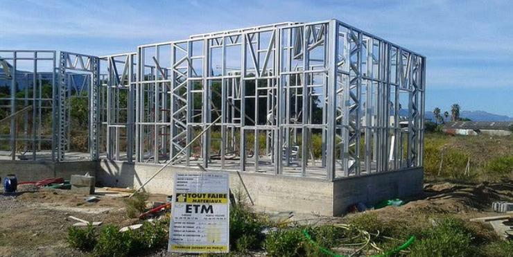
Qui a fianco possiamo prendere visione delle fasi principali di costruzione a secco del nostro sistema **BetonWood** su struttura a telaio in amiera metallica.
