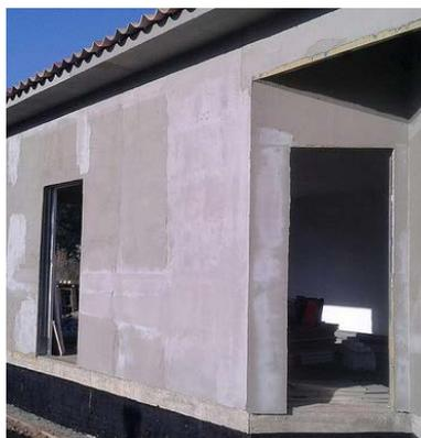
Si parte a srotolare, dall'alto verso il basso, la rete in fibra di vetro ad alta densità densità 360 gr/m<sup>2</sup> **BetonNet Glass 360**; la sovrapposizione delle reti deve essere di 10 cm circa.
