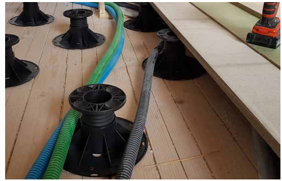
Posa dei supporti livellati a laser e fissati alla base con viti a legno e alla testa con viti con preforo
