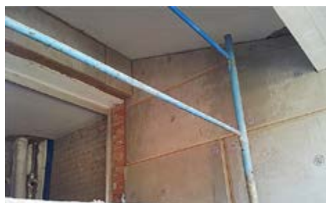
Realizzazione di angoli nel sistema per cappotto termico Betontherm fiber dry
