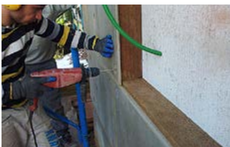
Realizzazione di angoli nel sistema per cappotto termico Betontherm fiber dry
