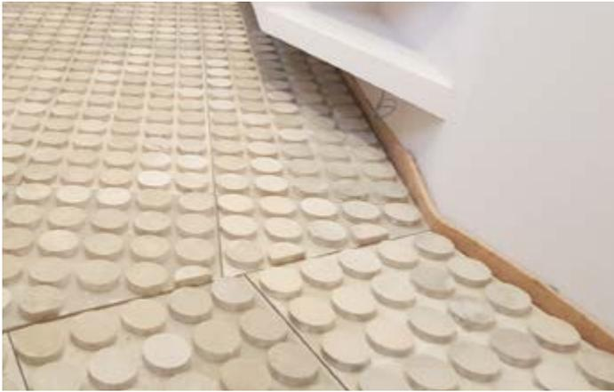
Tenere da parte la striscia flessibile in fibra di legno **FiberTherm® Soundstrip** in quanto verrà usata in seguito nei giunti di dilatazione fra i pannelli radianti tipo **Betonradiant®** in corrispondenza dei passaggi tra una stanza e l'altra in caso si voglia cambiare la natura del rivestimento superficiale (ad es. si voglia passare dal parquet al rivestimento ceramico o viceversa).
