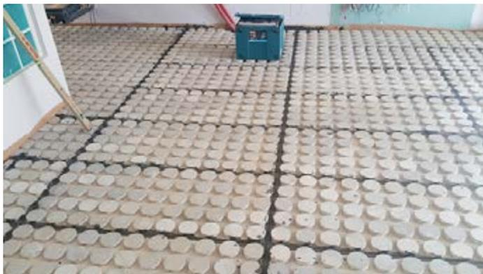
Una volta stuccate tutte le fughe fare essiccare il materiale di giunzione come indicato dalla scheda tecnica del produttore, e pulire i canali dalla polvere con strumenti di aspirazione.
