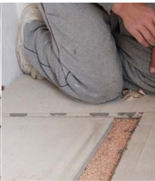
Disposizione giunti di dilatazione al di sotto di porte battenti ed in corrispondenza del passaggio tra una stanza e l'altra.
