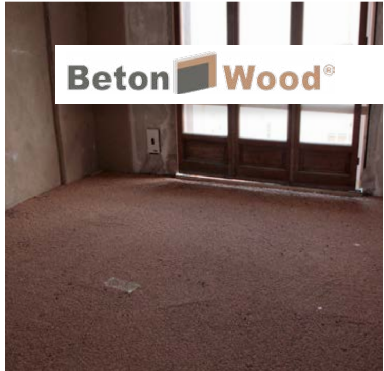
Staggiatura del granulato tipo Cork Granules nel sistema a massetto sopraelevato BetonWood® tongue&groove
